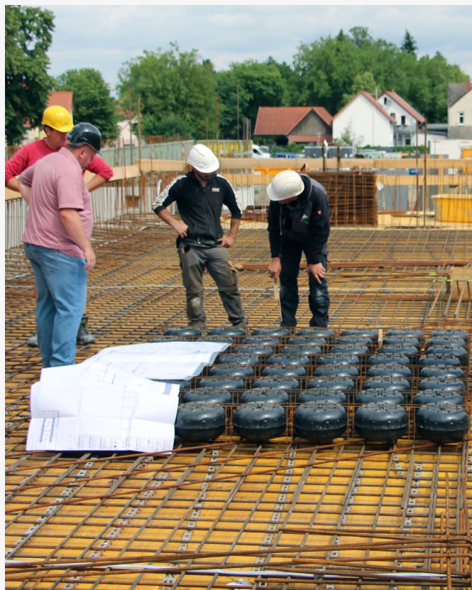
Stavebná porada: Plán inštalácie je precízne realizovaný. Zdroj: Aller-Weser-Klinik gGmbH.
