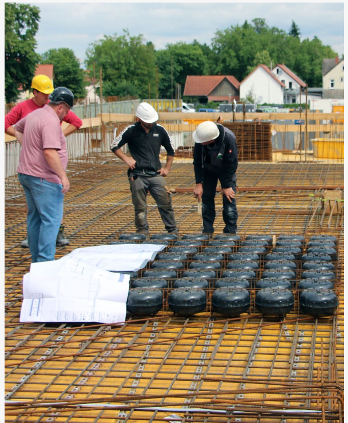
Baubesprechung: Der Verlegeplan wird genau umgesetzt. Quelle: Aller-Weser-Klinik gGmbH.
