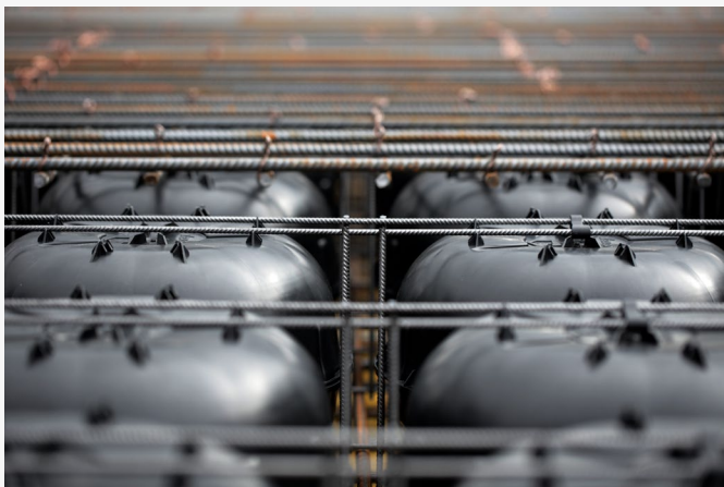
Fertig eingebaute Cobiax SL Module. Quelle: Heinze Cobiax Deutschland GmbH
